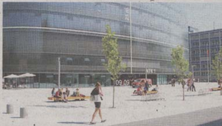
Šest nadzemních pater, tři patra garáží a depozitářů v podzemí. Knihovna stojí přímo v centru budov ČVUT.
